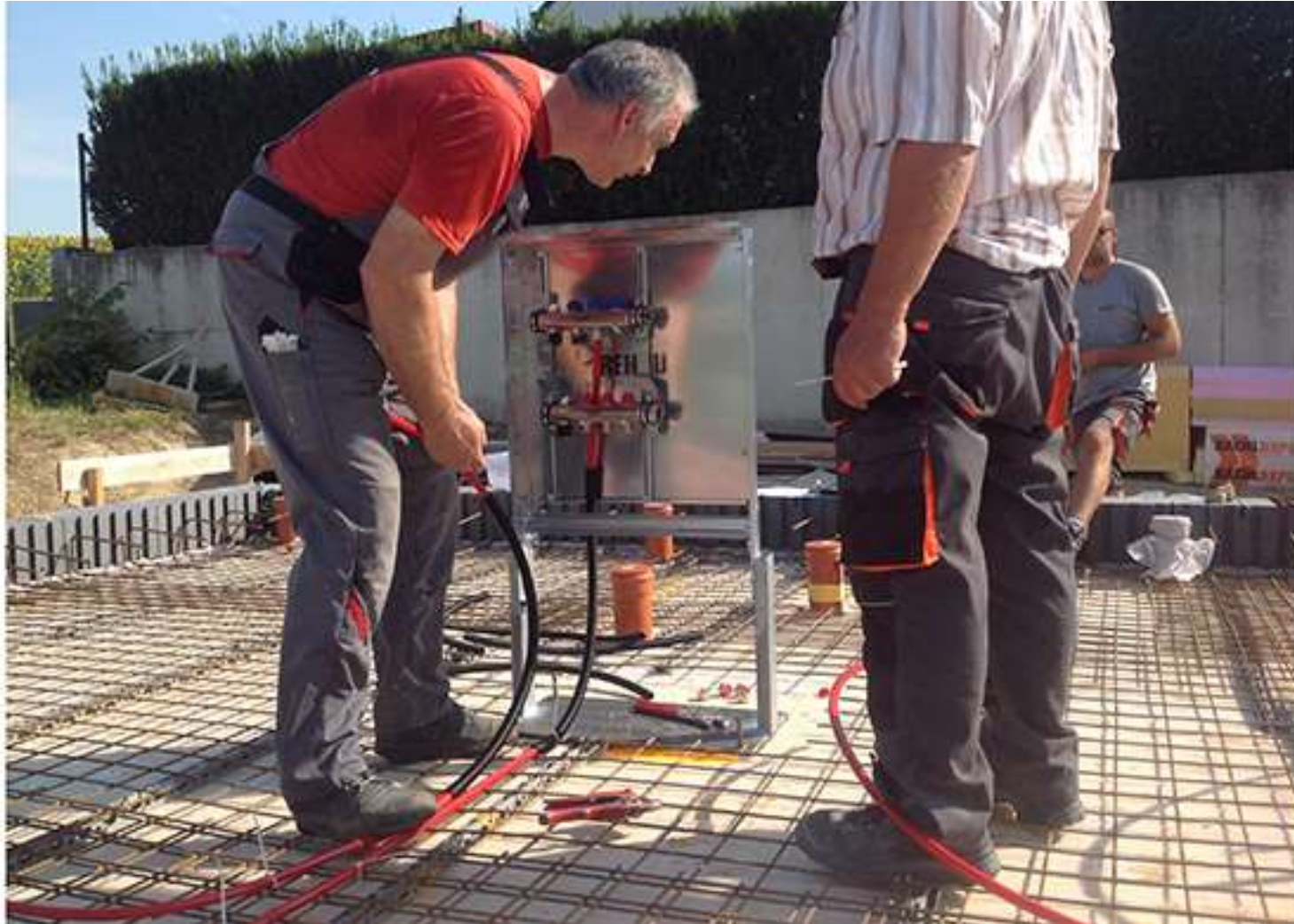
Anschluss an den Verteilerkasten, Schutzüberzug für Schläuche
