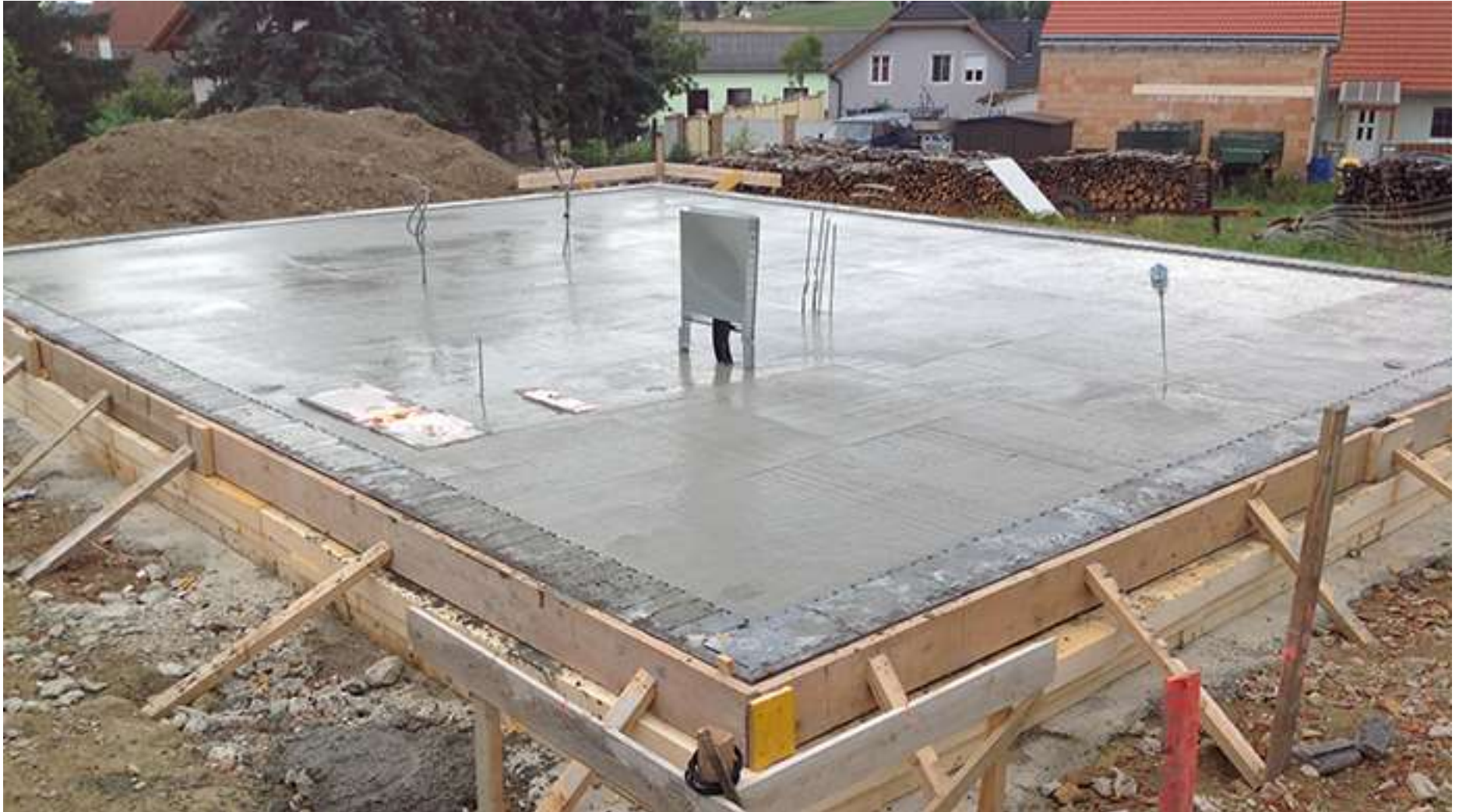
Erdgeschoßplatte fertig
