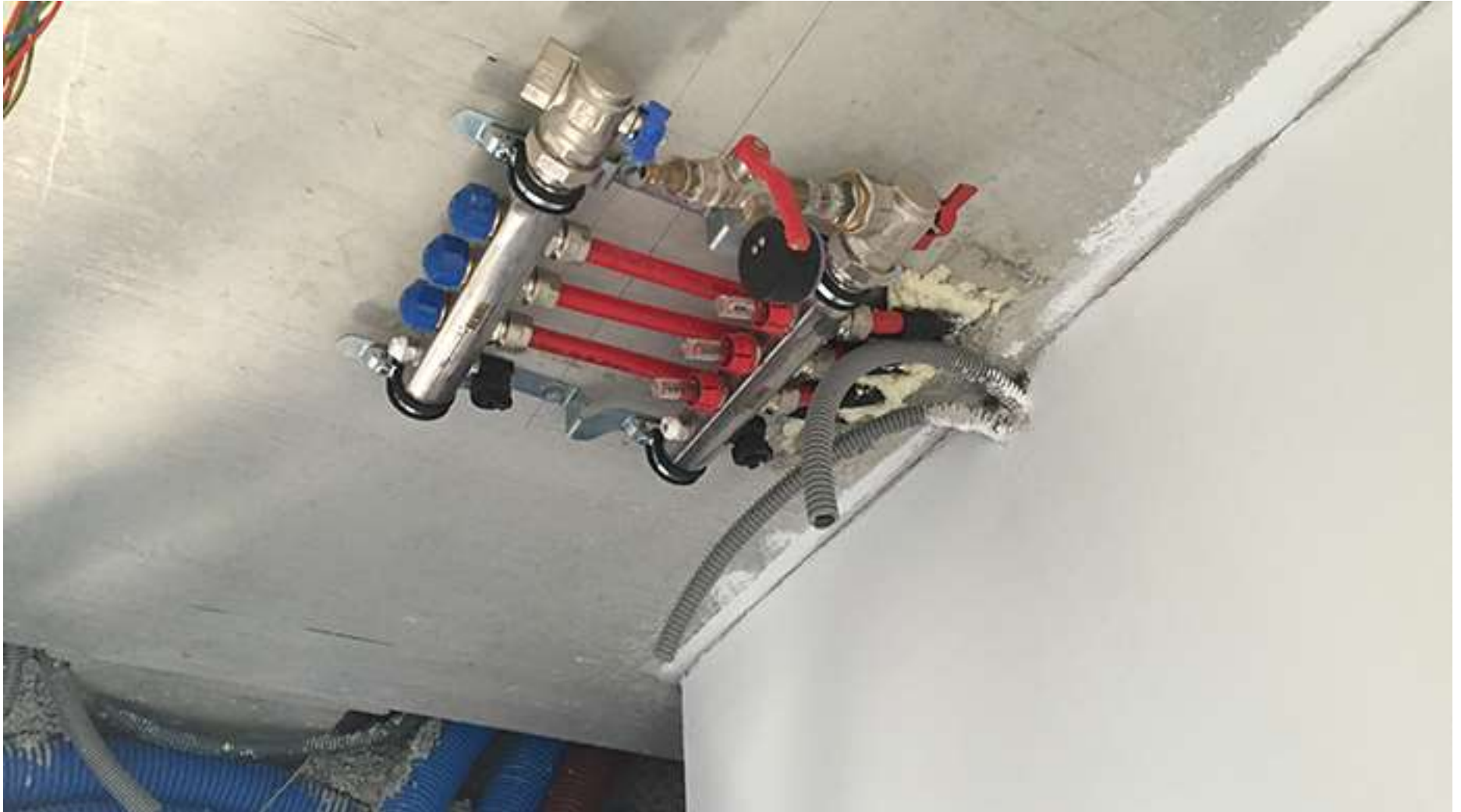
Verteilerkasten, Decke
