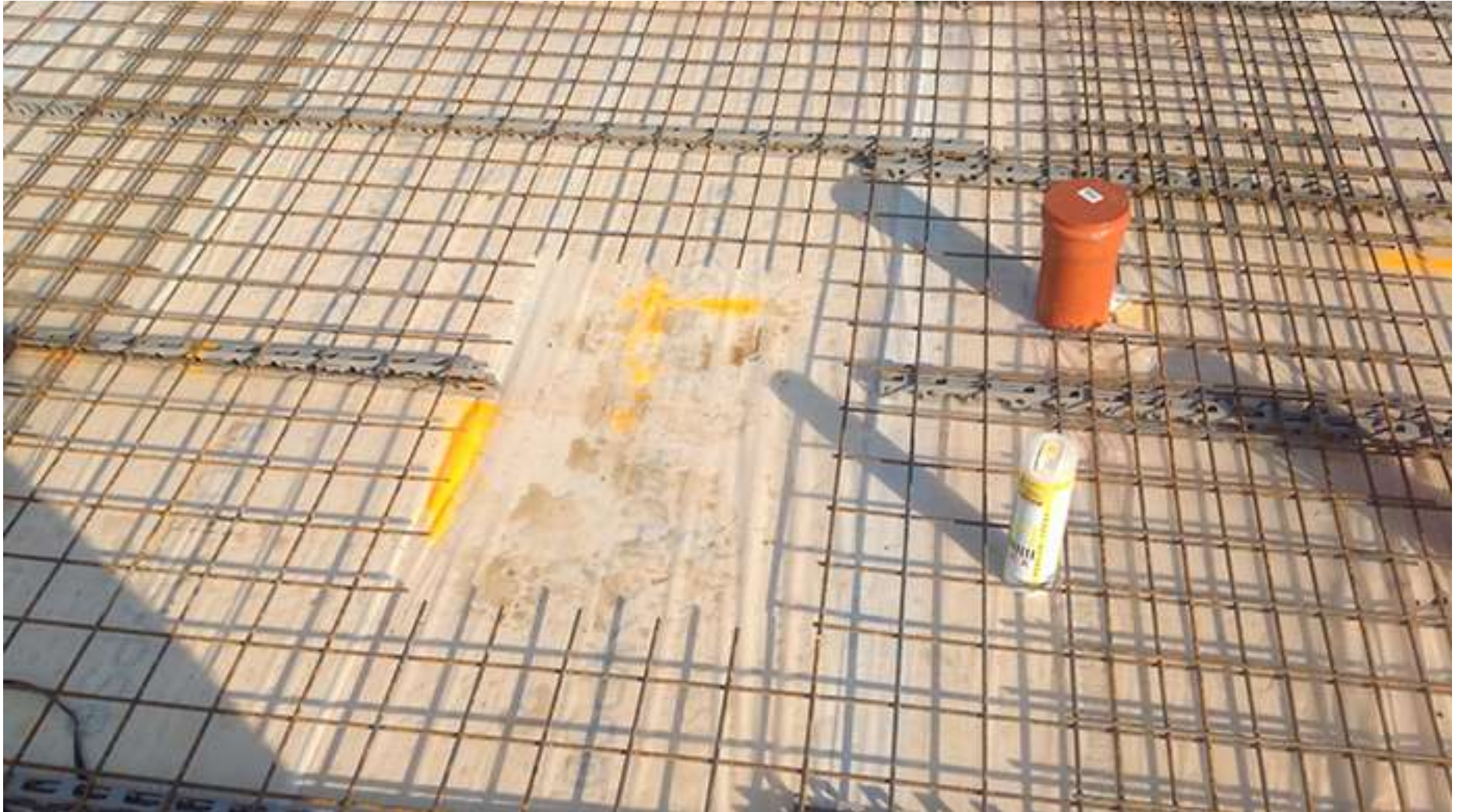
Fläche für Montage Verteilerkasten
