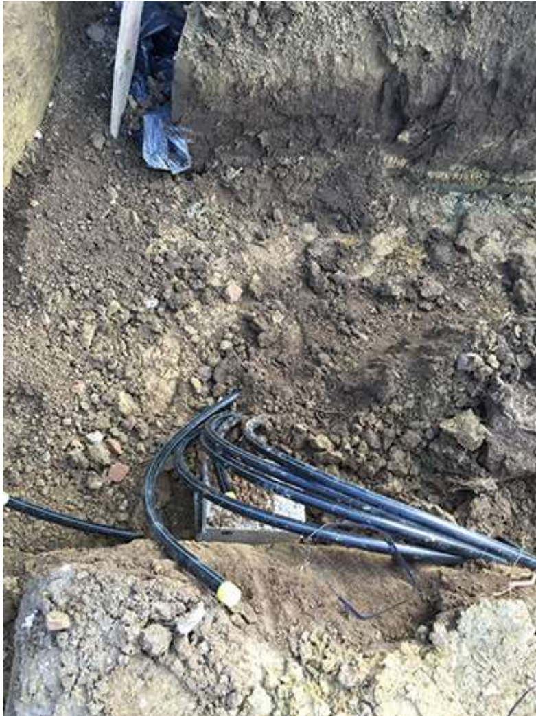
Erdreichwärmetauscher – verlegte Leitungen im Gartenbereich
