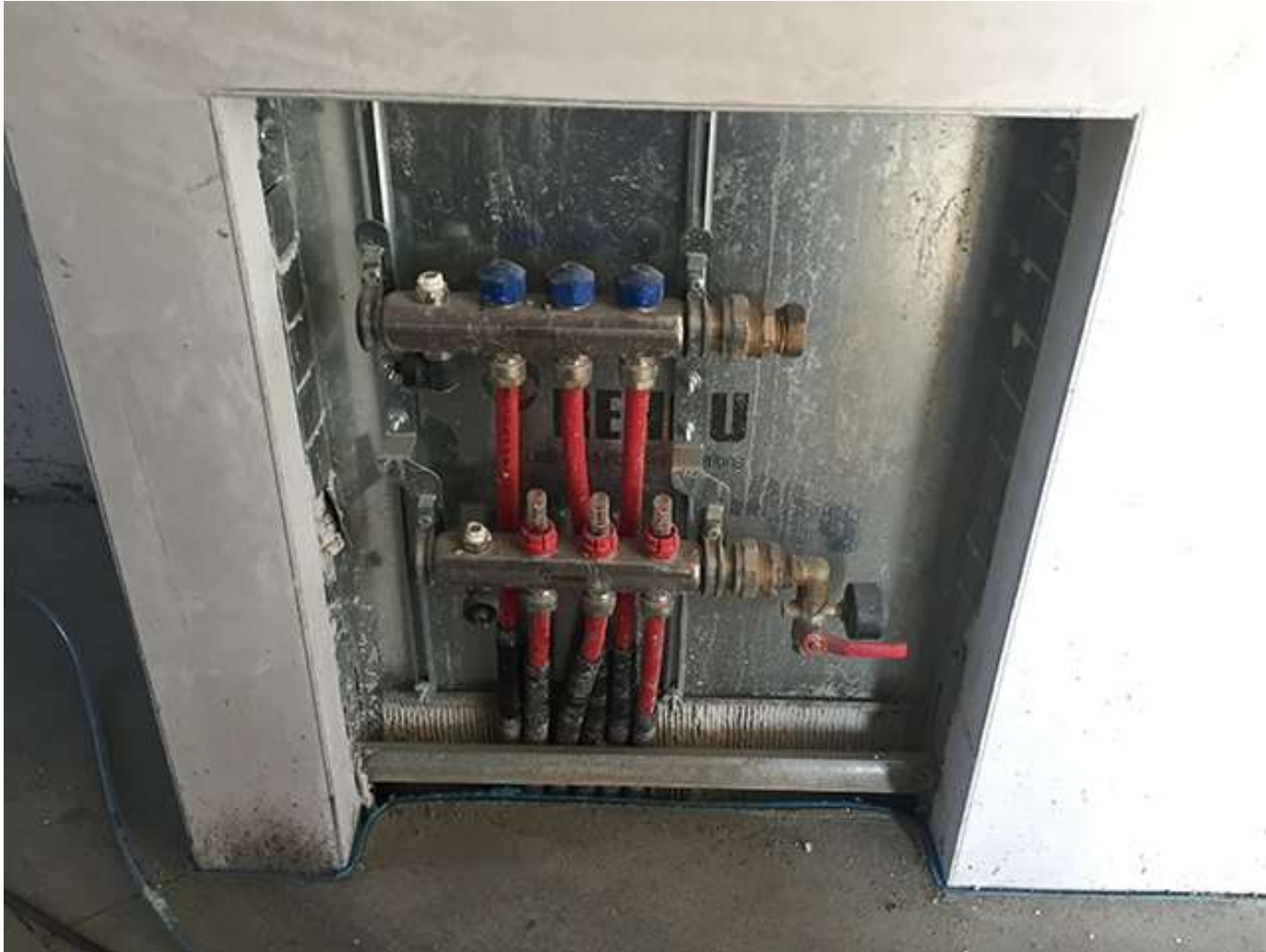
Verteilerkasten, eingebaut
