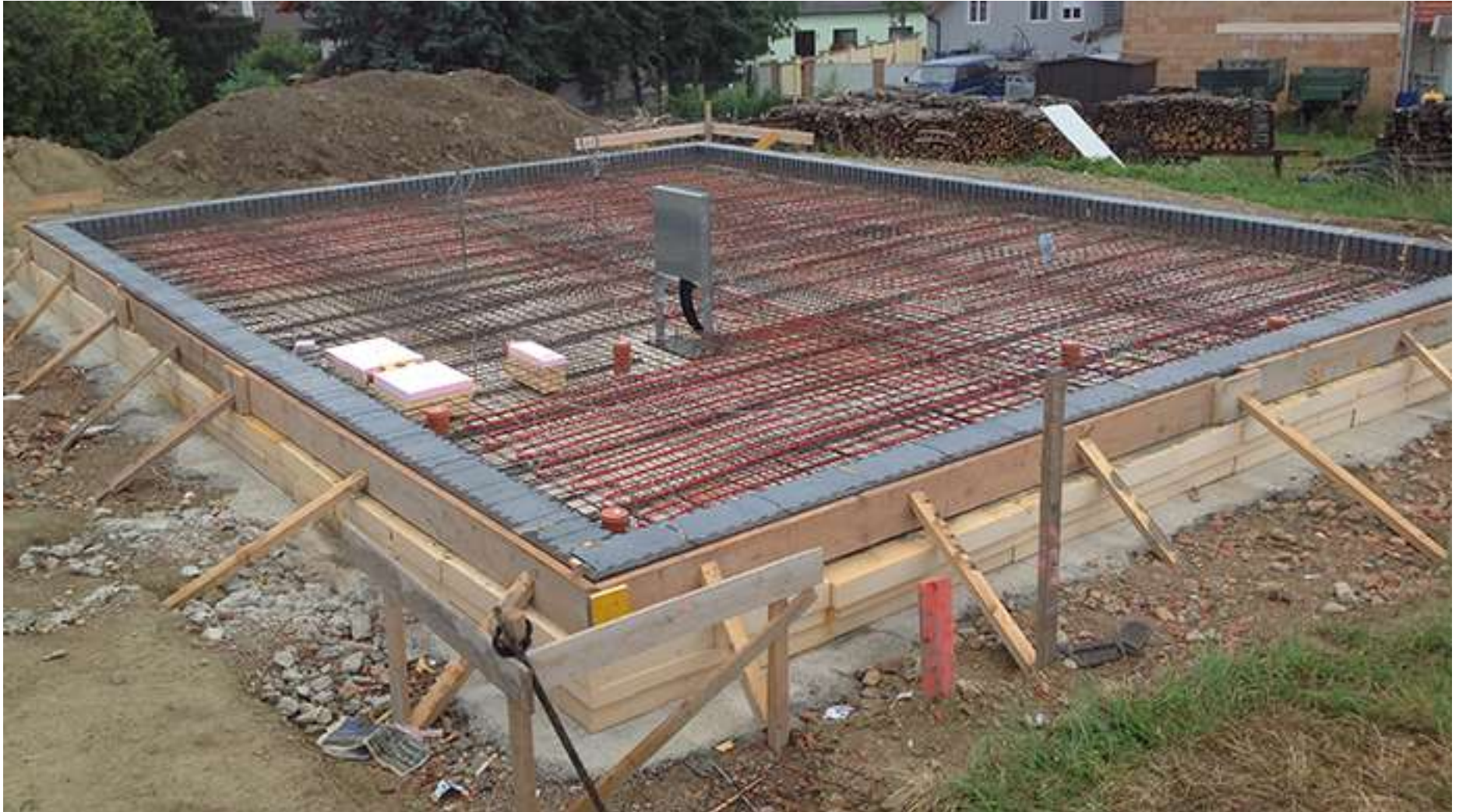
Erdgeschoß mit verlegten Schläuchen
