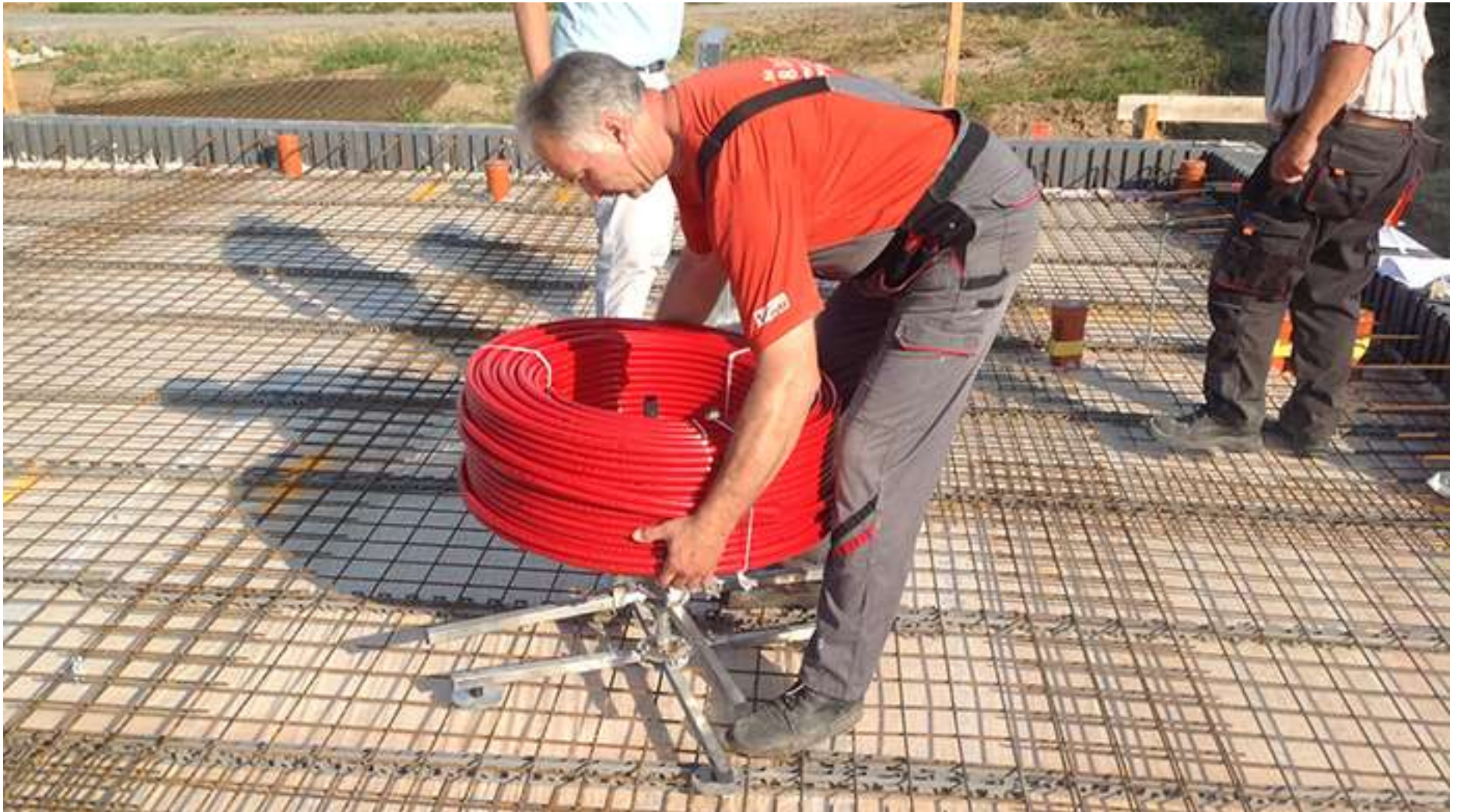
Endlosschlauch zur Abhängung der Rohrleitungen
