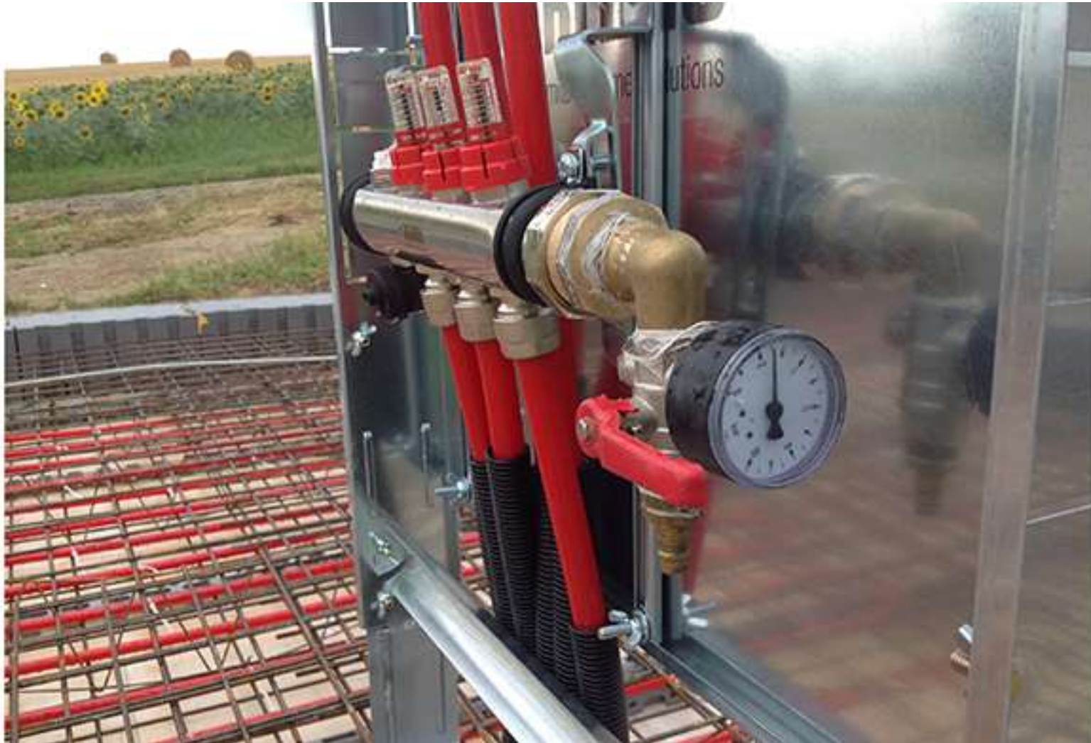
Verteilerkasten mit Manometer, Druckprüfung vor, während und nach Betonierarbeiten
