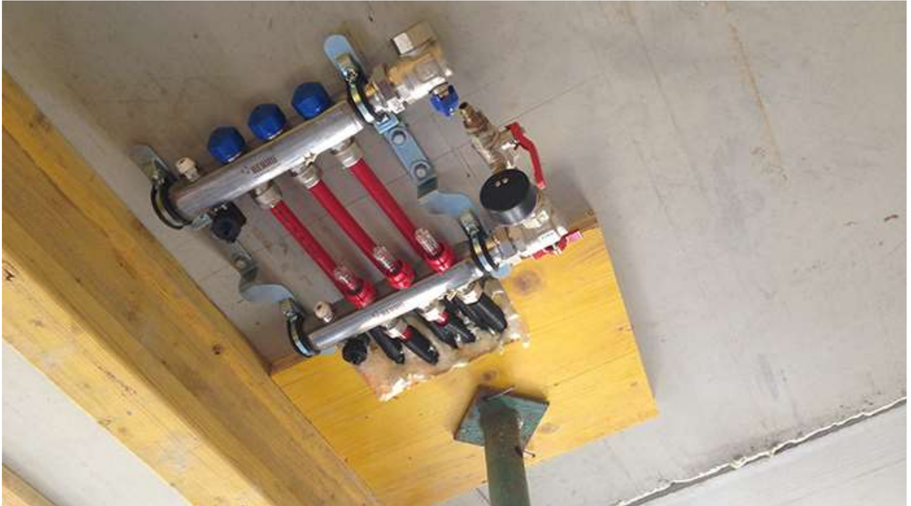
Verteilerbalken an Deckenuntersicht für die darüber liegenden Heizkreise (Decke EG)
